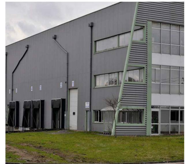
Plateforme logistique Logipharma
